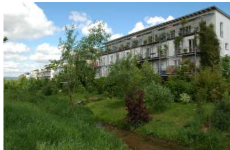
Traitement de l'eau pluviale et aménagement paysager
