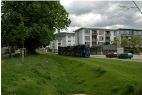
Exemple de fossé à Fribourg
