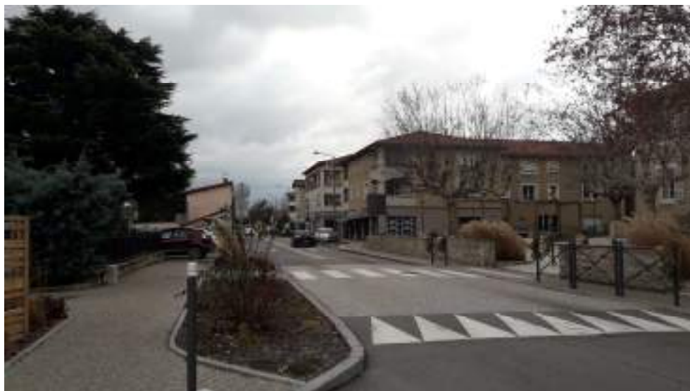
Les aménagements sur la RD 30 depuis le Nord
