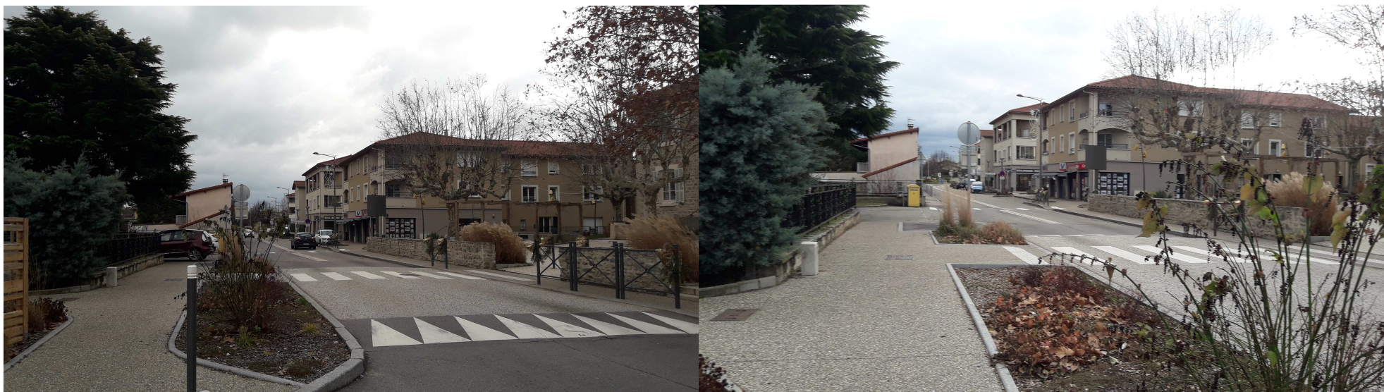
Les aménagements sur la RD 30 depuis le Nord
