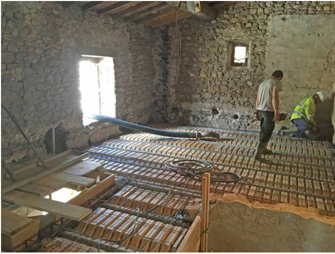
Coulage de la dalle du palier et d'une pièce de l'étage
