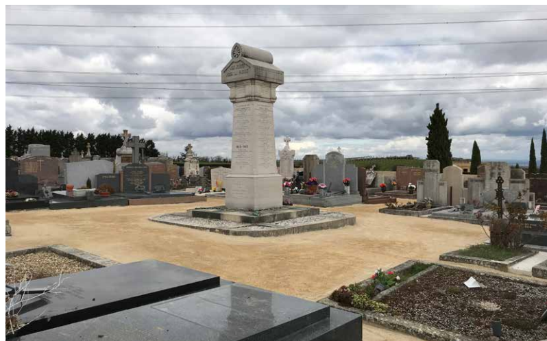
Résultat après décaissement, pose de géotextile et de 60 tonnes de gravier
